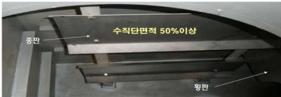
[그림 V-154] 물탱크 내부 방파판
