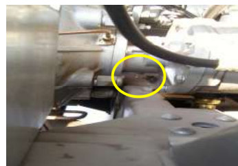
[그림 V-259] 그랜드 패킹 누수 확인
