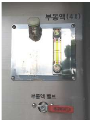
[그림 V-161] 부동액 탱크 및 지수밸브 부동액배관 연결부
