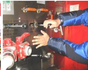
[그림 V-283] 역류방지 밸브 이상 유무 확인(방수구 흡입 감촉)
