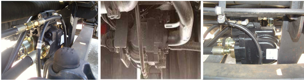
[그림 2-51] 소방 고가 · 굴절차 유압펌프 작동 및 누유 점검
