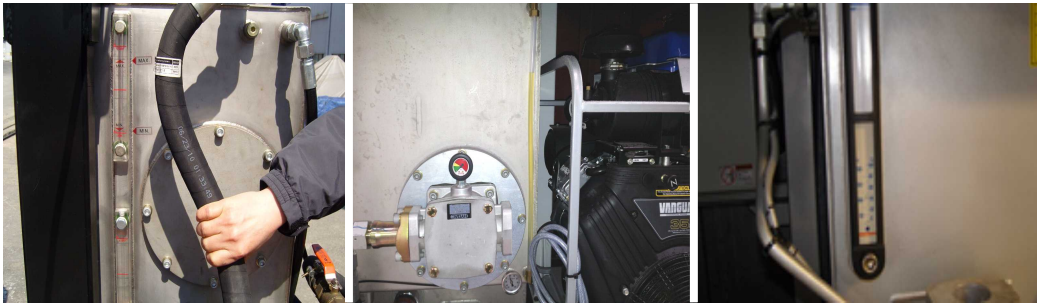
[그림 2-49] 소방 고가 · 굴절차 유압작동유 점검
