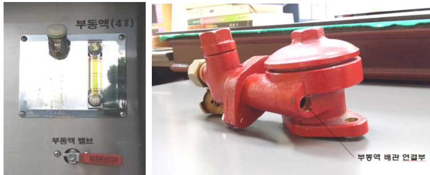
[그림 3-56] 부동액 탱크 및 주입라인(지수밸브)
