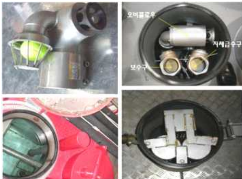
[그림 3-52] 물탱크 내부(위), 상부 맨홀 장치들(아래)
