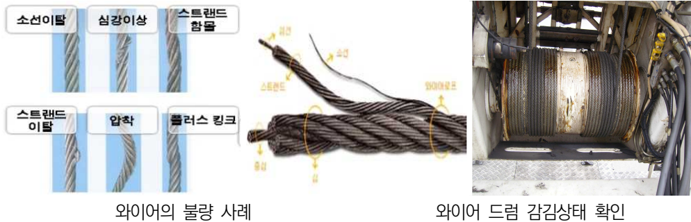
[그림 2-63] 소방 고가 · 굴절차의 와이어 점검
