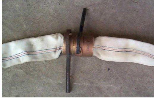
호스 개폐기(Spanner)를 이용한 소방호스 연결모습
