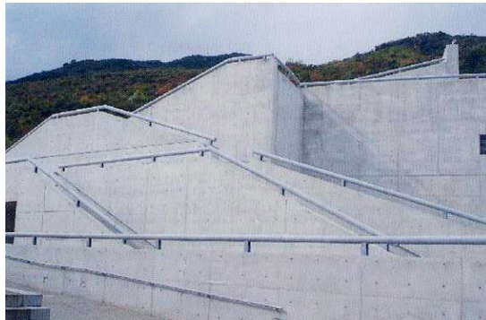
[그림 4-5] 철근콘크리트 건축물
